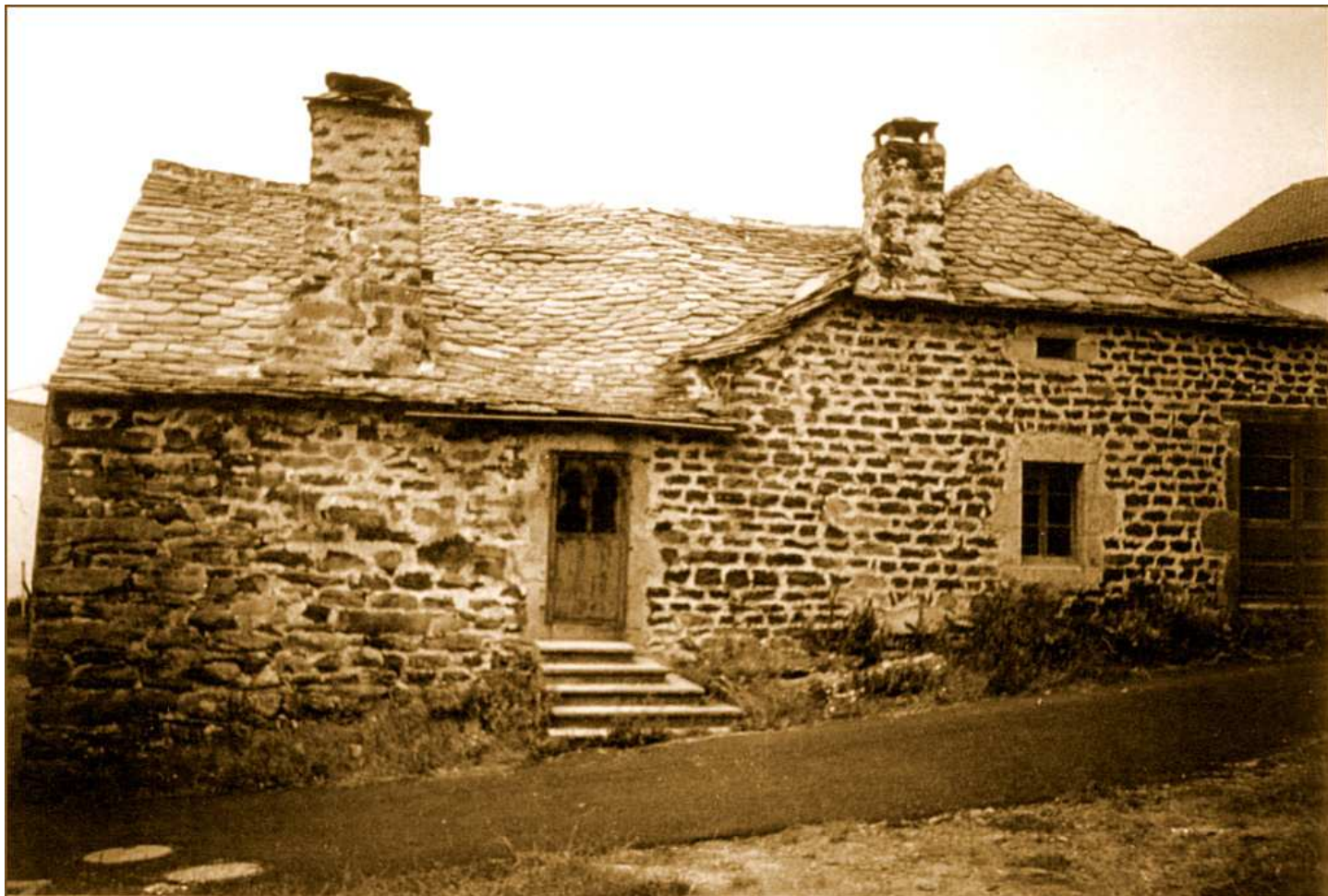
Peyrache avant sa réhabilitation.
